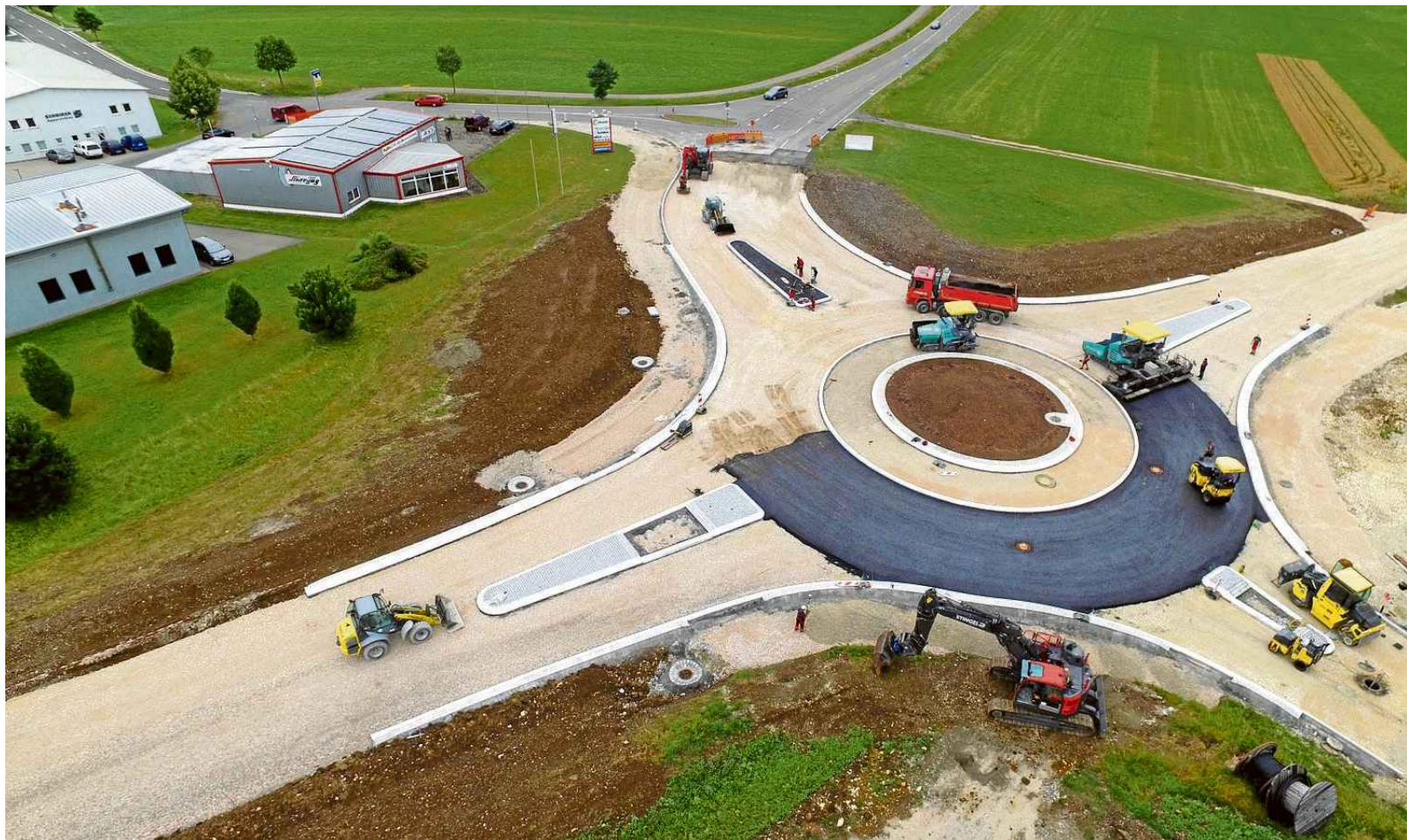
Das sind schon heftige Dimensionen. Die Firma Stingel hat eine Drohne in die Luft geschickt, um die Baustelle am Kreisel vor den Toren Meßstettens buchstäblich ins Bild zu rücken. Foto: Firmenfoto
